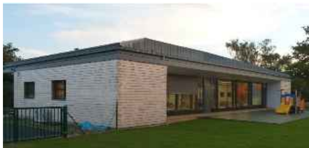
Maison de la petite enfance à Cormenon. Maître d'ouvrage : communauté de communes Collines du Perche.
